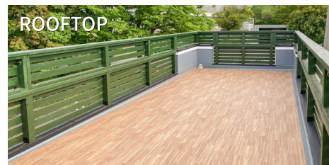
ROOFTOP 広さ約30m 2 、防水シート貼の屋上。(オプションの追加手摺で、手摺高110cmにできます)
