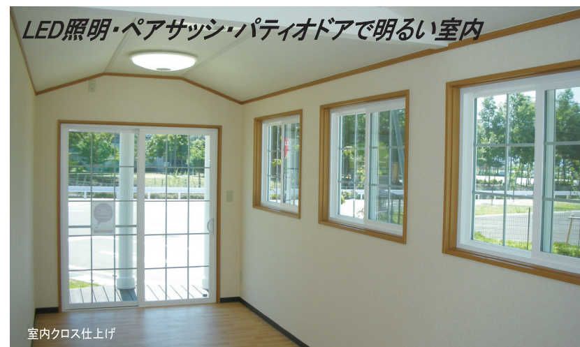
V-テラス8m・樹脂サイディング
