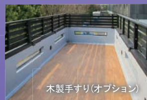
デッキ床面には撥水・滑り止め加工をしています
